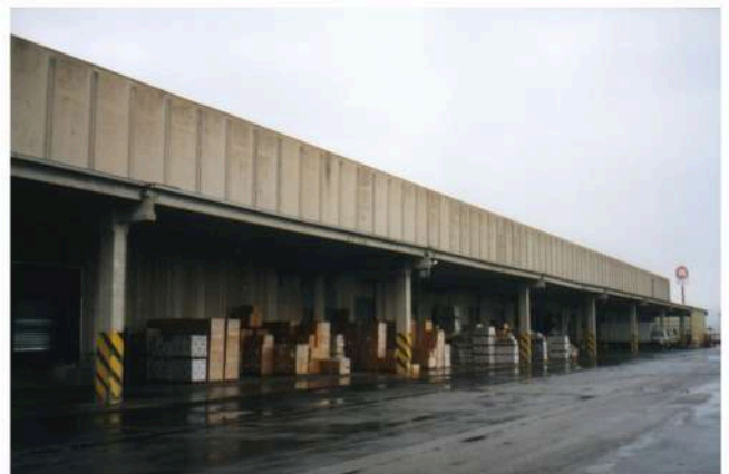
FIANO ROMANO: WAREHOUSE
