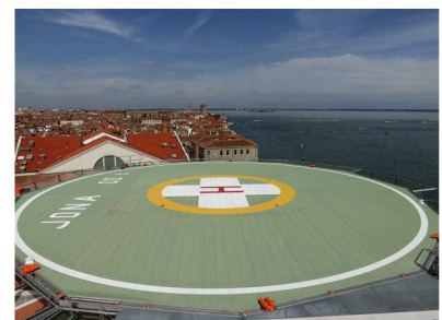
VUE DU PAVILLON JONA
