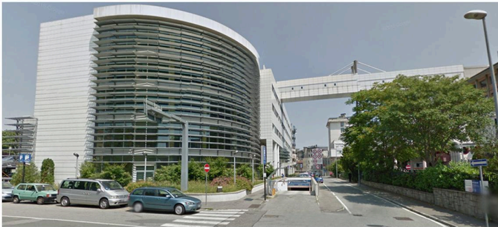
VISTA DELL'UNITÀ SPINALE CON IL COLLEGAMENTO ALL'OSPEDALE
