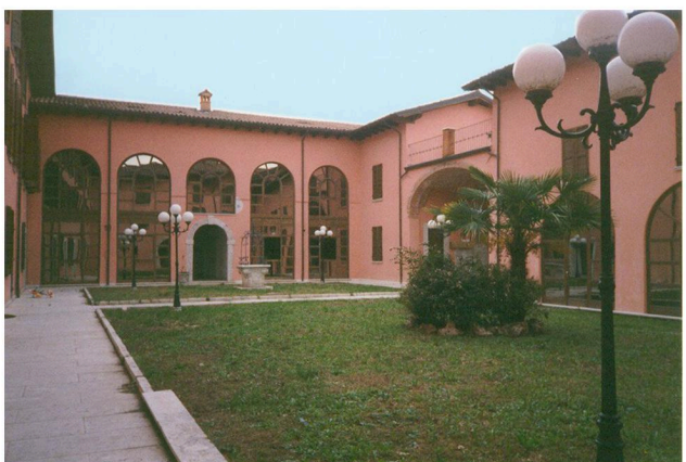
PADENGHE SUL GARDA: EDIFICIO ULTIMATO
