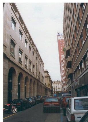
TORINO: EDIFICIO DA ULTIMARE
