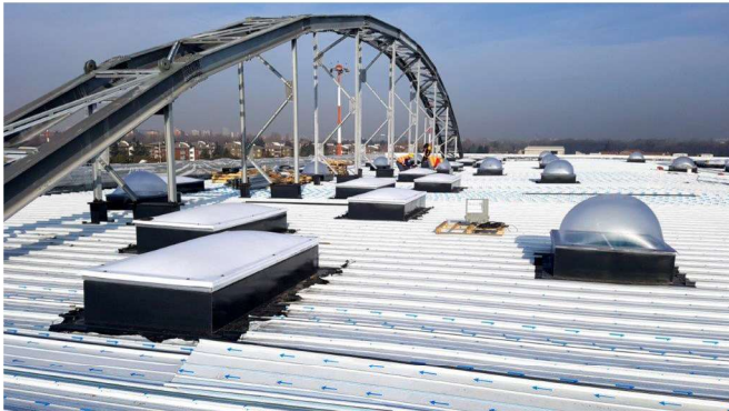
FOTOGRAFIA DI INSIEME COPERTURA
