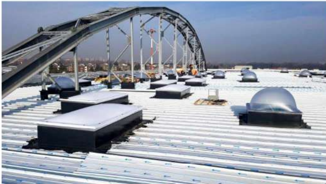
FOTOGRAFIA DI INSIEME COPERTURA
