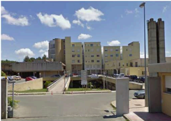
PRESIDIO SANITARIO DISTRETTUALE DI MACOMER
