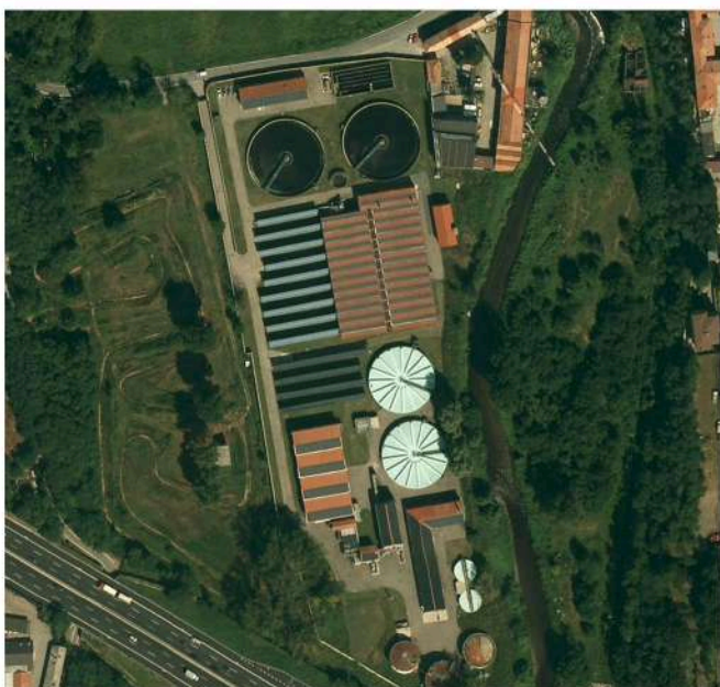
DEPURATORE DI OLGiate OLONA (VA)
