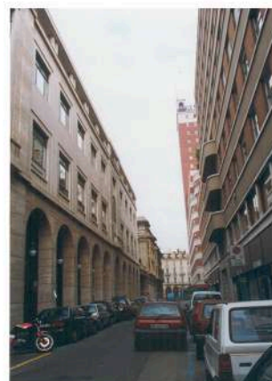
TORINO: EDIFICIO DA ULTIMARE
