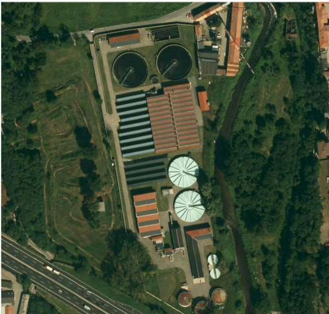
DEPURATORE DI OLGiate OLONA (VA)
