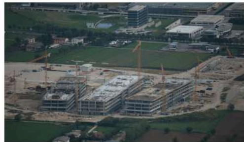
FASE DI REALIZZAZIONE
