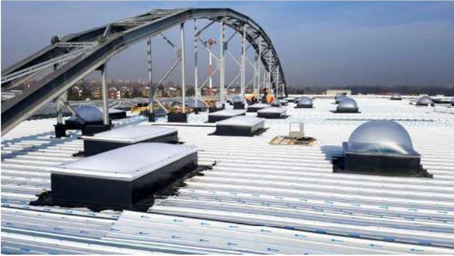
FOTOGRAFIA DI INSIEME COPERTURA
