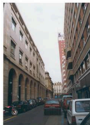
TORINO: EDIFICIO DA ULTIMARE
