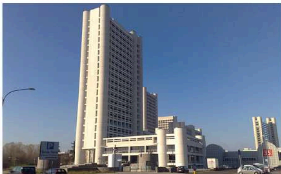
VISTA DEL COMPLESSO
